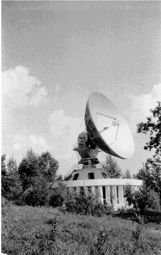
Рис. 2. Стационарно установленная антенна системы дальней космической связи Орбита [4] с механическим приводом, не предназначенная к перемещению
