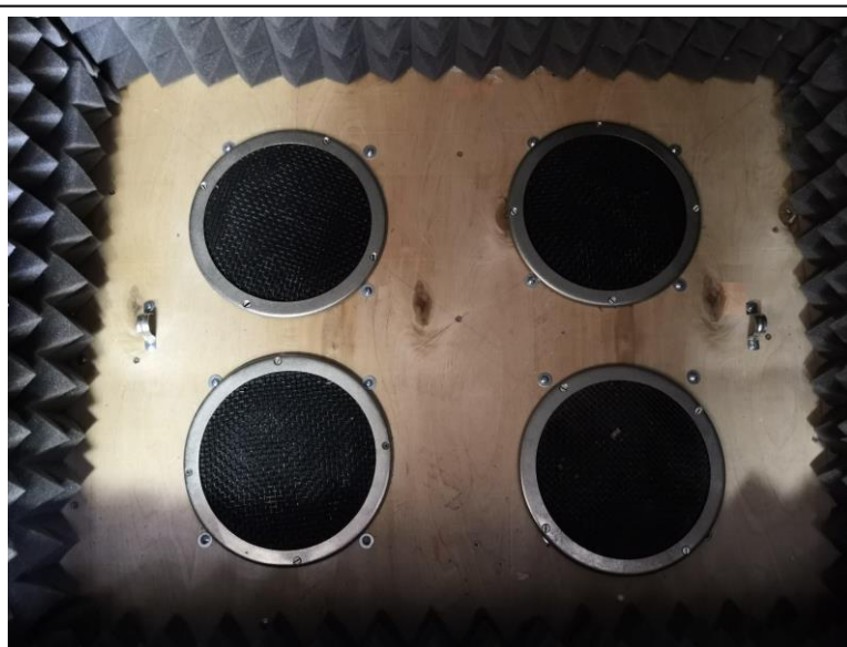
Рис. 1 - Вид на установленную панель с громкоговорителями
