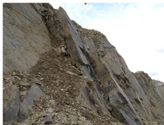
Рис.2. Уступ юго-западного борта карьера.
